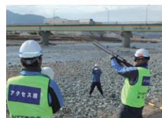
最大で100m程度の谷や河川を越える建設用鋼索発射銃M-300(ランチャー)
