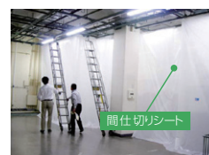
簡易間仕切り設置状況 (設備撤去スペース)
