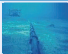
水底ケーブル 800km
