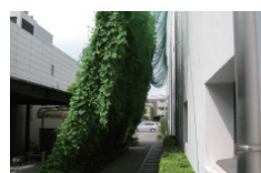
東京支店 新宿ビル
