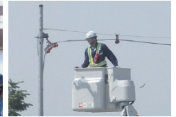
災害後の通信ケーブルの応急復旧作業
