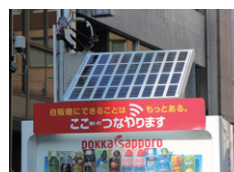
自動販売機上部に設置された太陽光発電パネル
