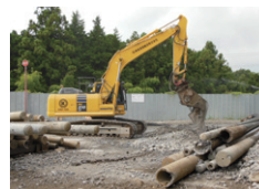
重機により破砕される電柱
