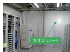
簡易間仕切り設置状況 (通信設備スペース)
